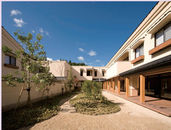
運営する特別養護老人ホーム「愛厚ホーム設楽苑」外観
